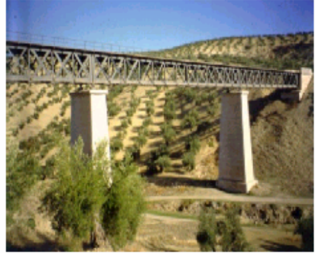
Viaducto metálico del Arroyo de la Piedra del Águila
